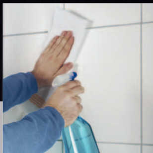
Untergrund vorreinigen und trocknen lassen.
